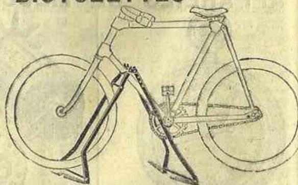
2165. Support "Le Stable" en fortes lames d'acier finement émaillées avec filets or, crochets en contact avec la machine garnis coton tressé. Ce nouveau support parfaitement étudié maintient les 2 roues soulevées et celle d'avant est guidée. Comme son nom l'indique, la machine est maintenue dans une stabilité parfaite pour le nettoyage et le graissage. Il se replie sur lui-même et ne tient lorsqu'on ne s'en sert pas, qu'une place insignifiante. Modèle solide et de fabrication parfaite. 3.
