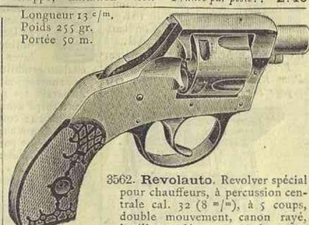
**3562. Revolauto.** Revolver spécial pour chauffeurs, à percussion centrale cal. 32 (8 m/m), à 5 coups, double mouvement, canon rayé, barillet se démontant à la main. Ce modèle de forme réduite tout en étant d'une grande puissance est admirablement en main et l'absence de toute aspérité extérieure permet de le loger facilement en poche..... *20. »*
