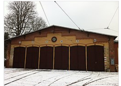
6-gleisiger (älterer) Teil der Wagenhalle des Straßenbahnmuseums Halle
